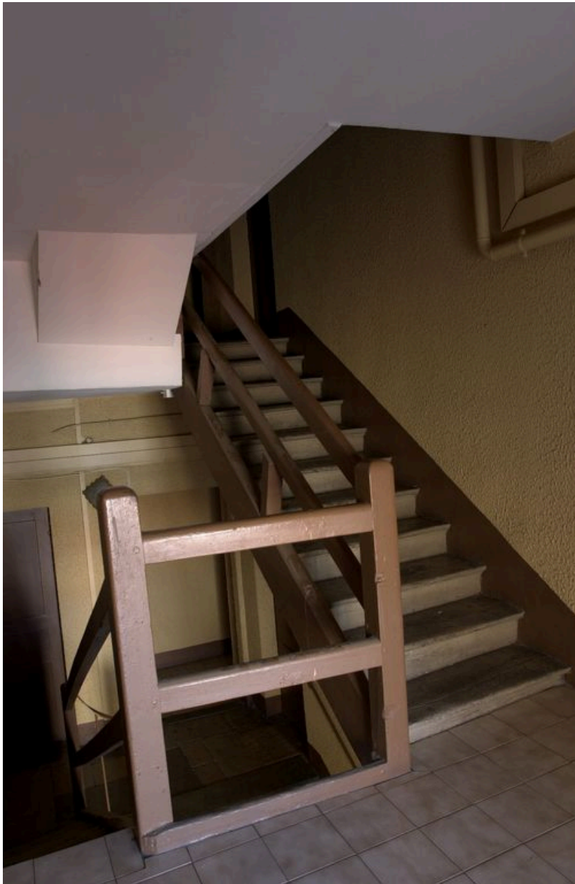
La dernière volée de l'escalier
