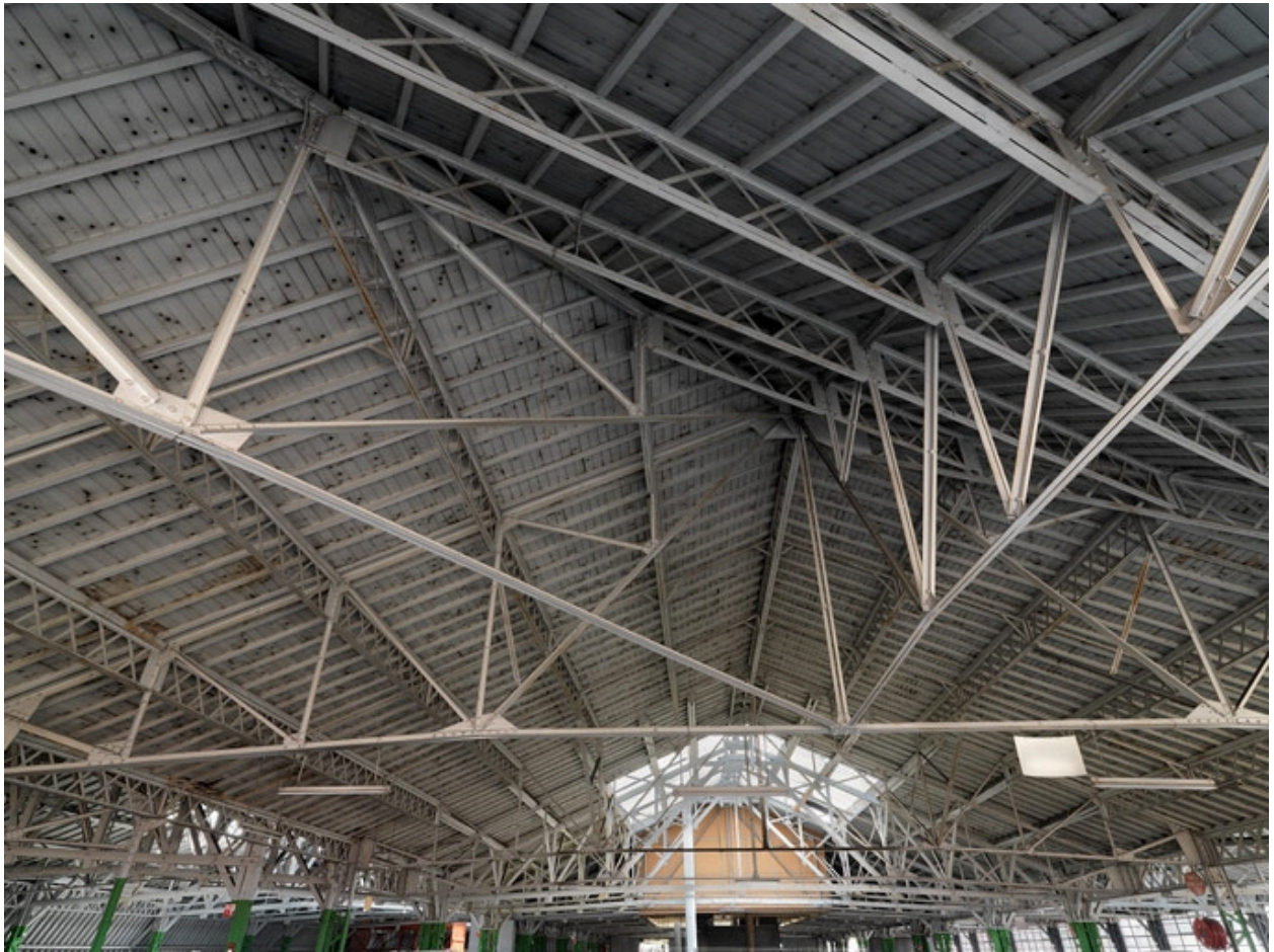
Ve d'ensemble de la charpente mixte bois et fer du 5e étage
