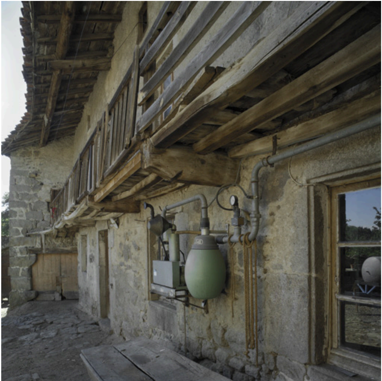
Vue latérale de la façade du logis, depuis le nord.
