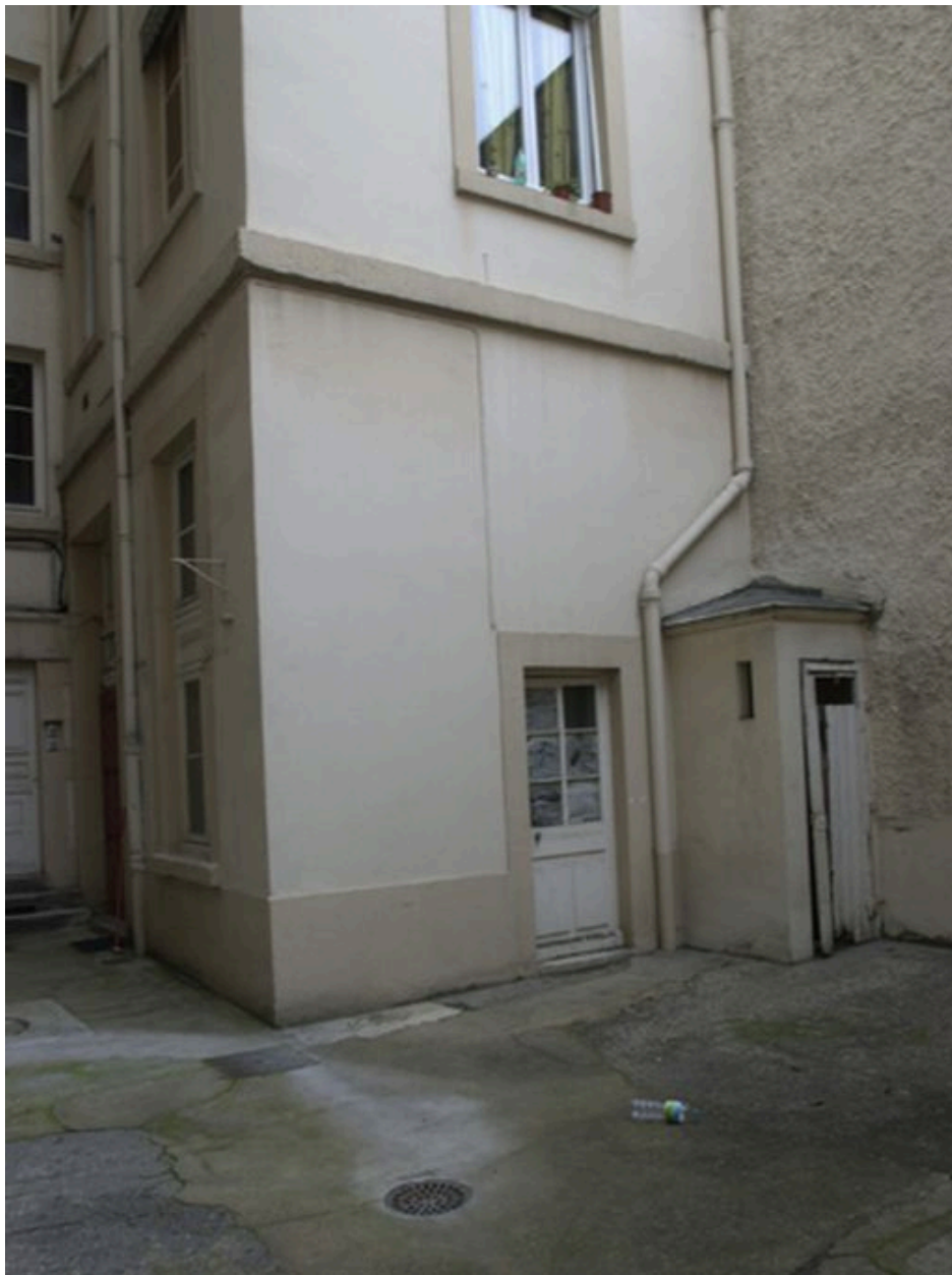
Vue du rez-de-chaussée
