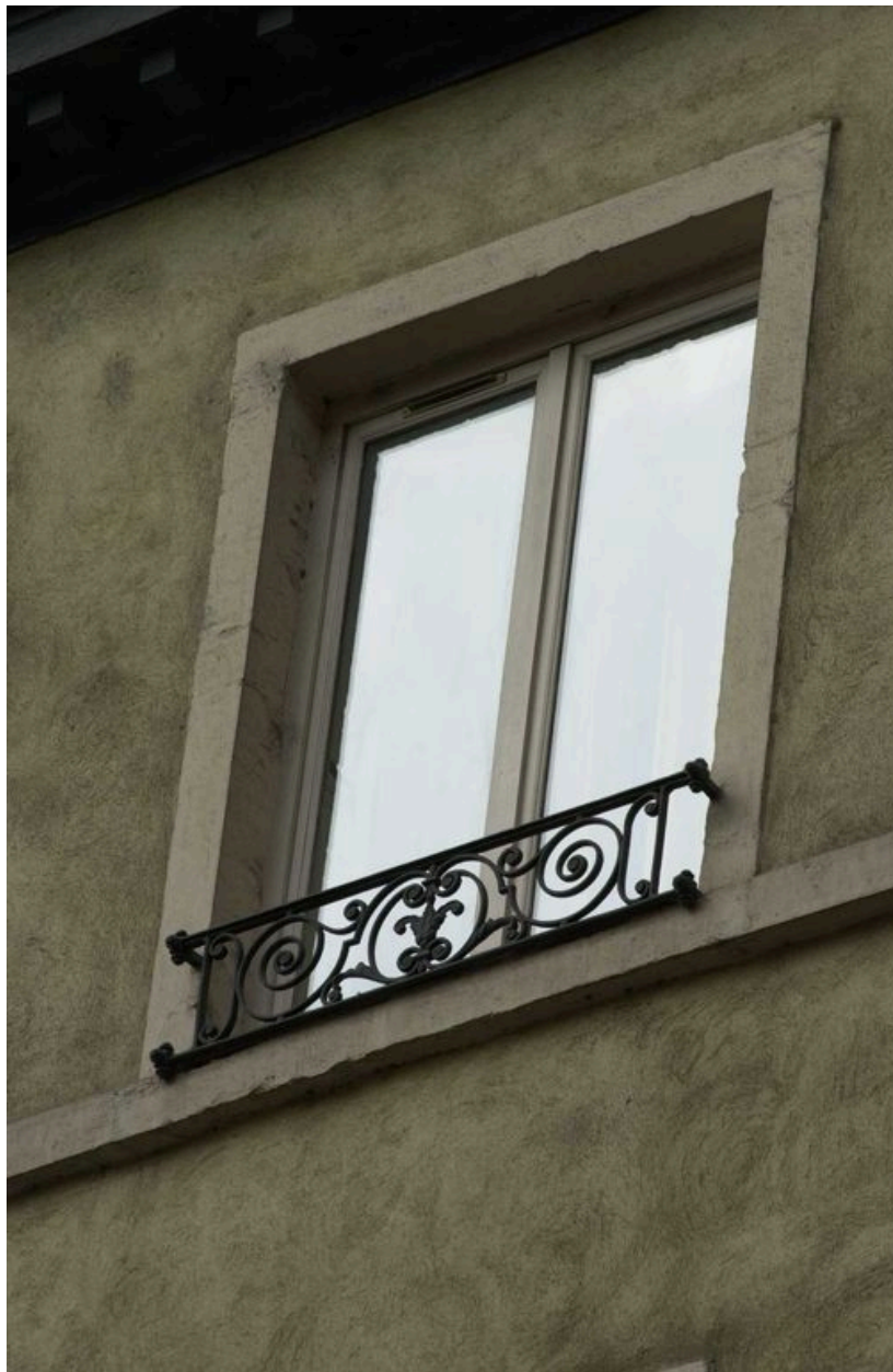
Détail d'un garde-corps, 3e étage Grande rue de la Guillotière
