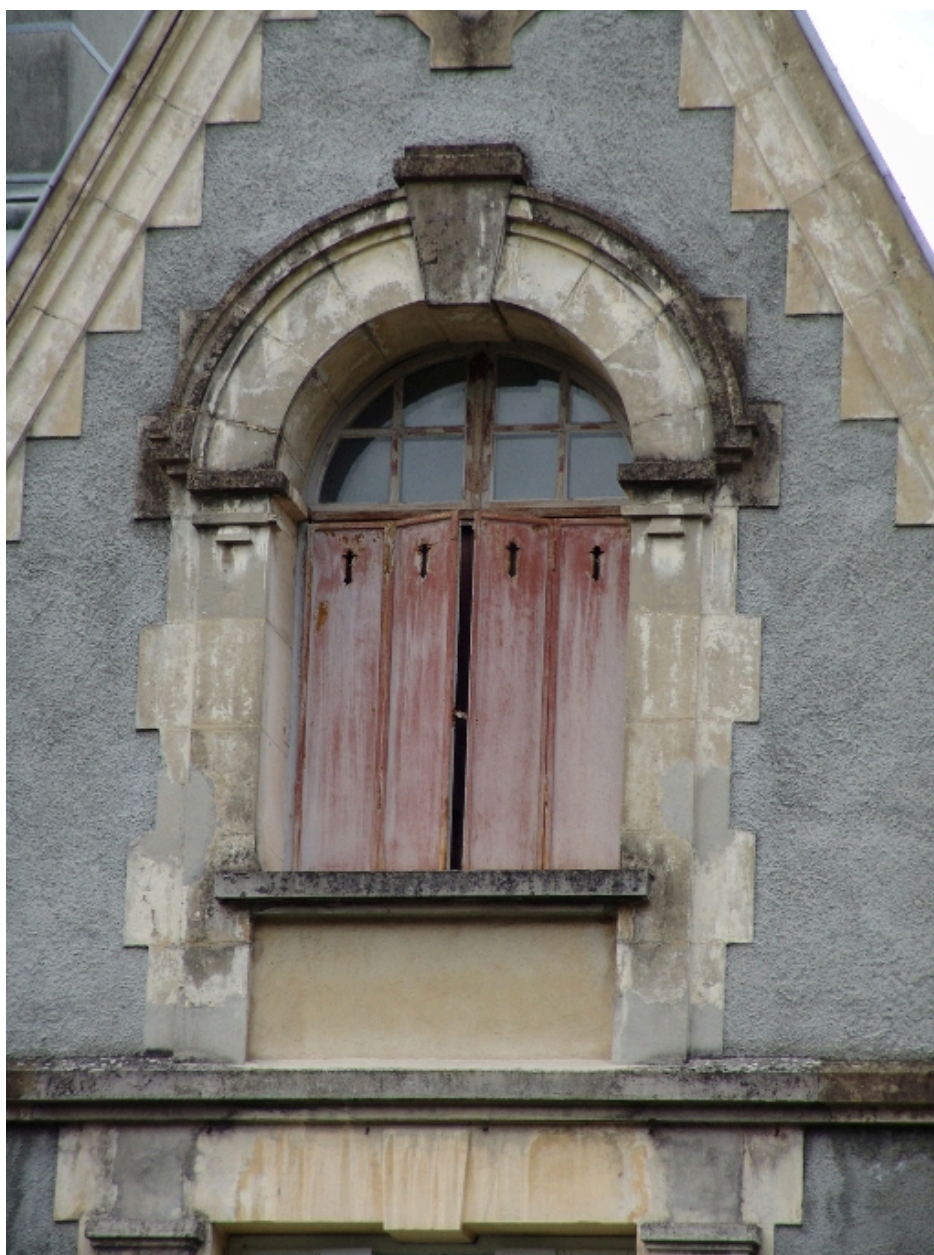
Baie dans le pignon
