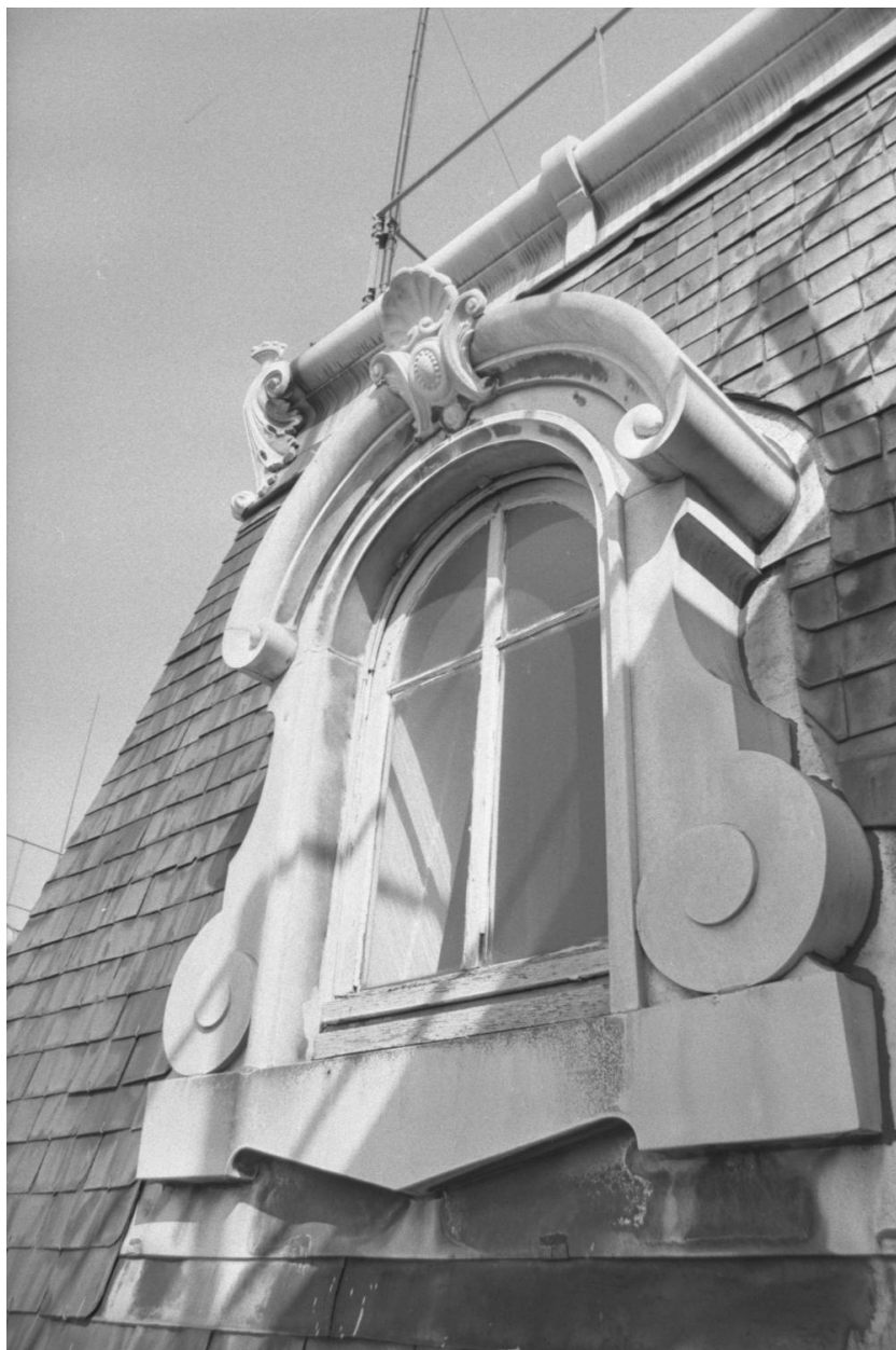
Petite lucarne ornée. Pavillon EB, toit ouest, partie nord
