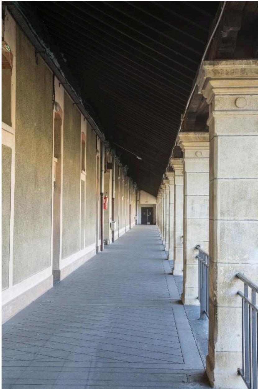
Bâtiment A. Galerie du 1er étage
