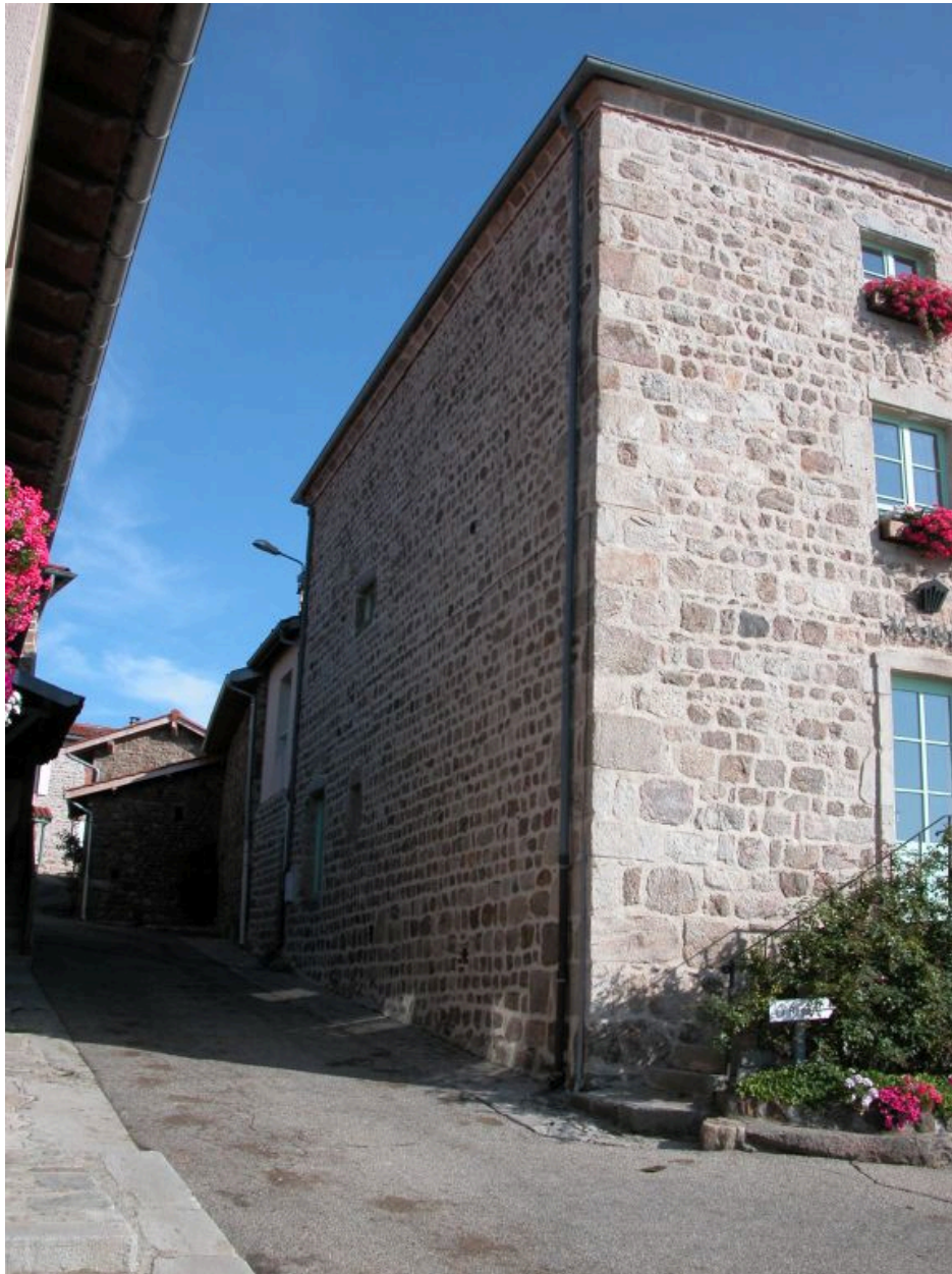
Vue d'ensemble de la façade arrière de la mairie.
