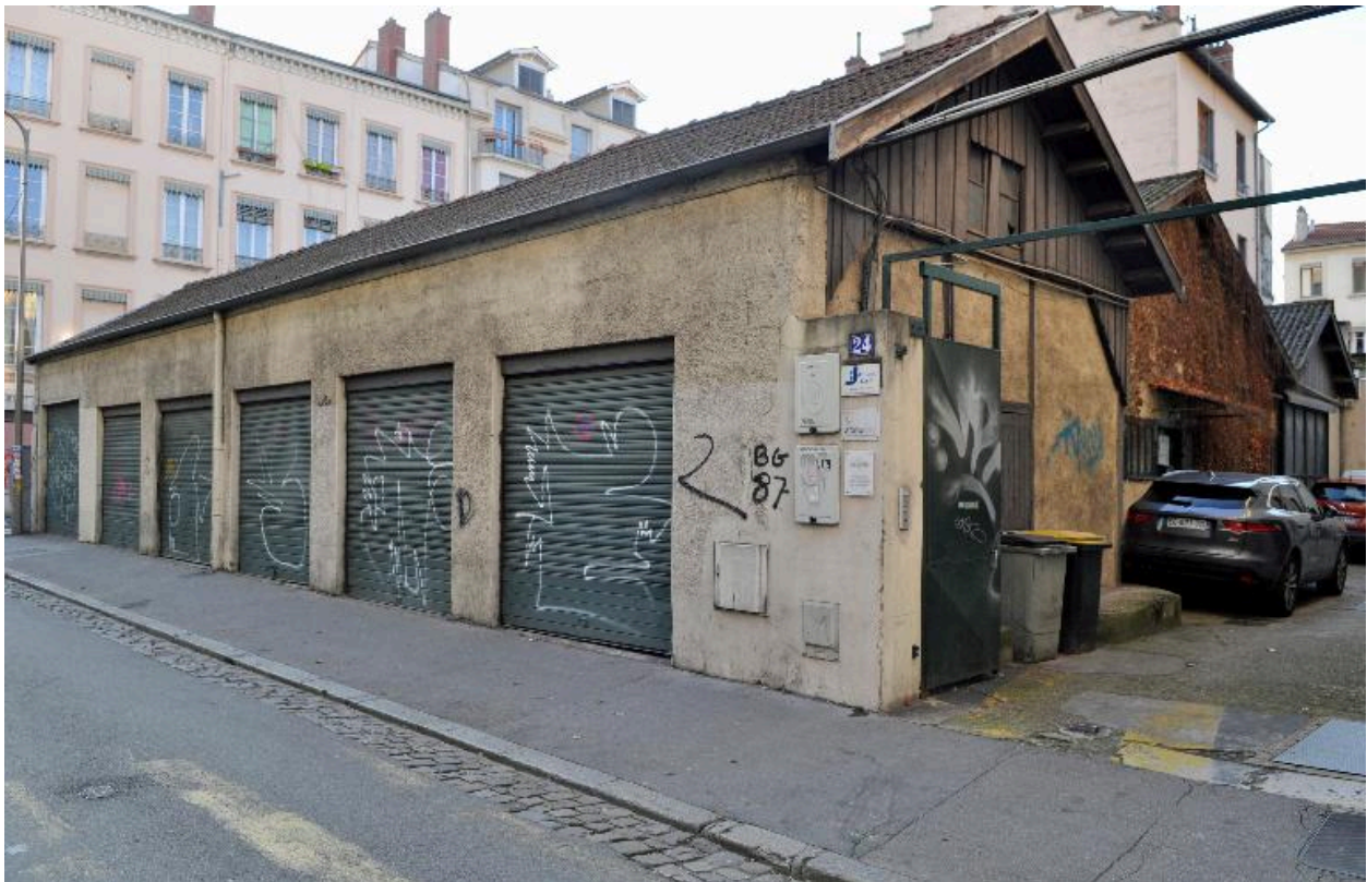
Ateliers sur la parcelle de l'immeuble
