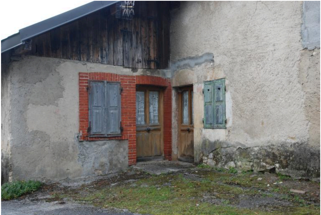
Ferme (2017 B52 1047, 2511), non repérée. Vue côté rue.
