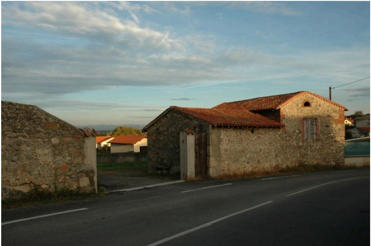
Vue d'ensemble depuis le chemin.
