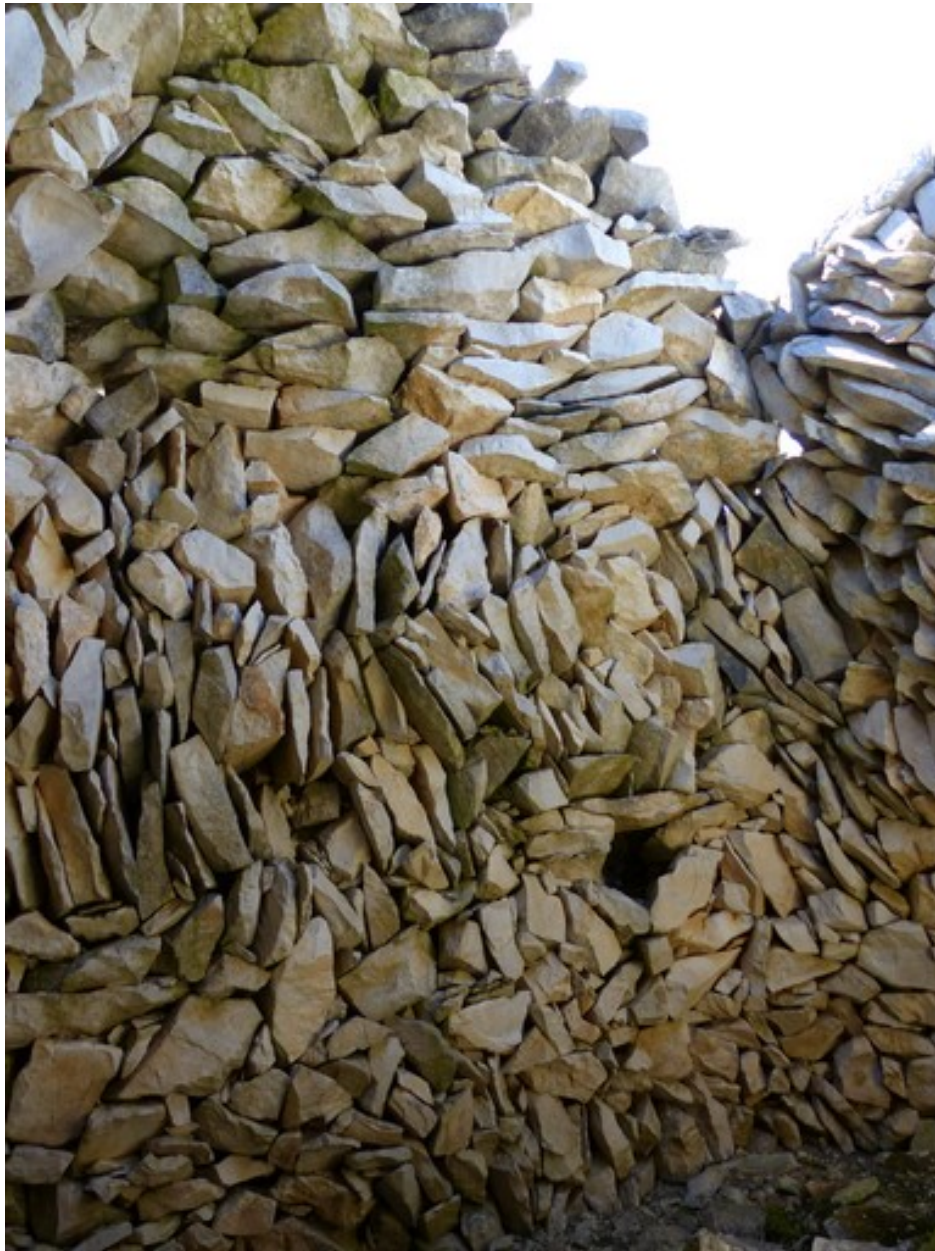
Travée ouest. Mur sud, coupole encorbellée sur départ clavé.
