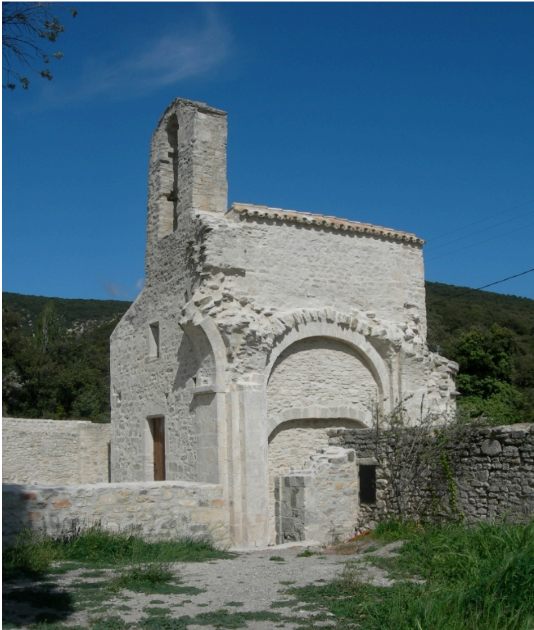
Chapelle restaurée, vue d'ensemble, prise du sud-ouest.
