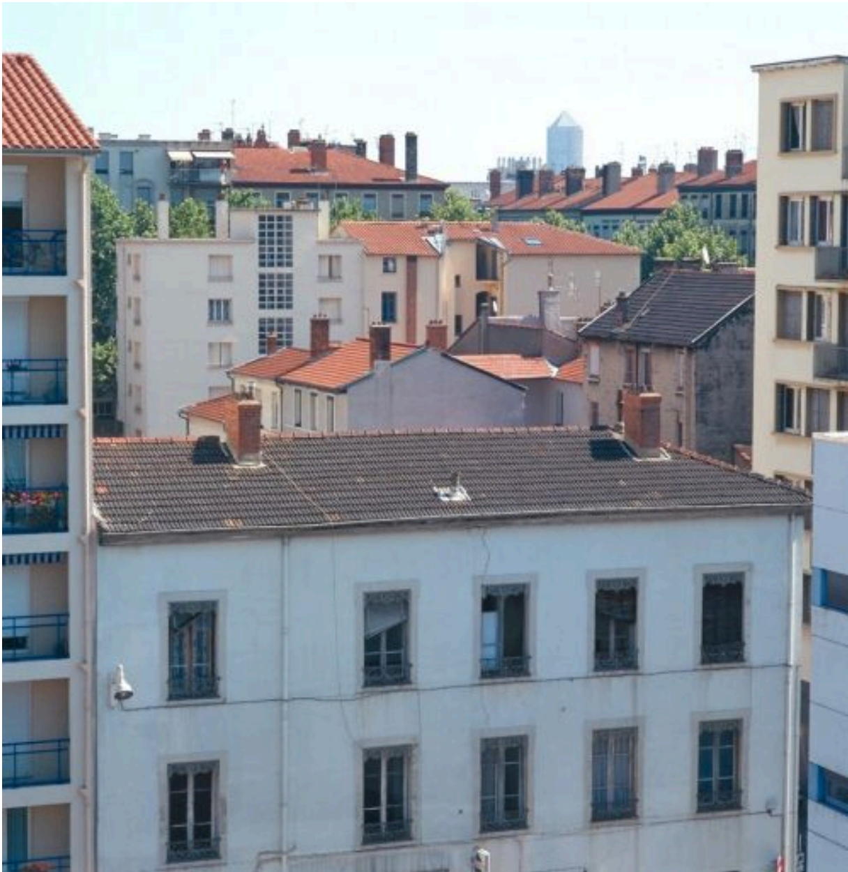
Élévation postérieure depuis le toit du collège Jean-Monnet
