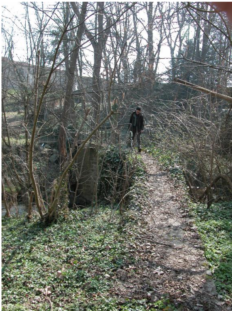
Vue d'ensemble du tablier de la passerelle.
