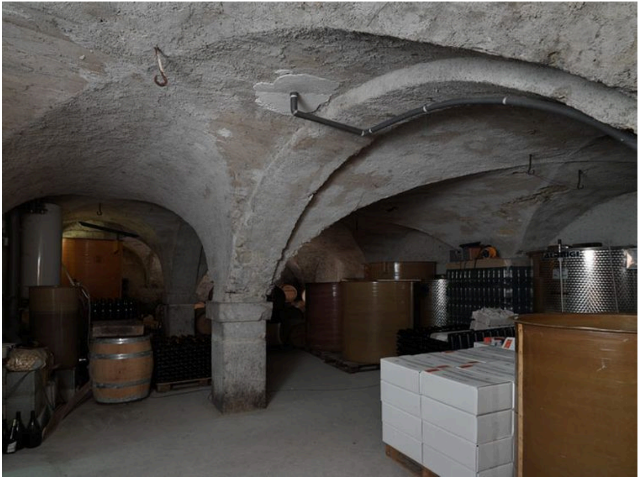
Vue d'ensemble de la cave à vin voutée.
