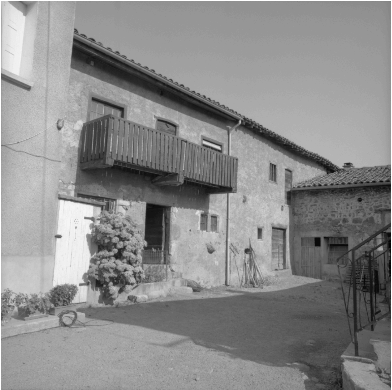
Vue d'ensemble du logis ancien et de l'étable.
