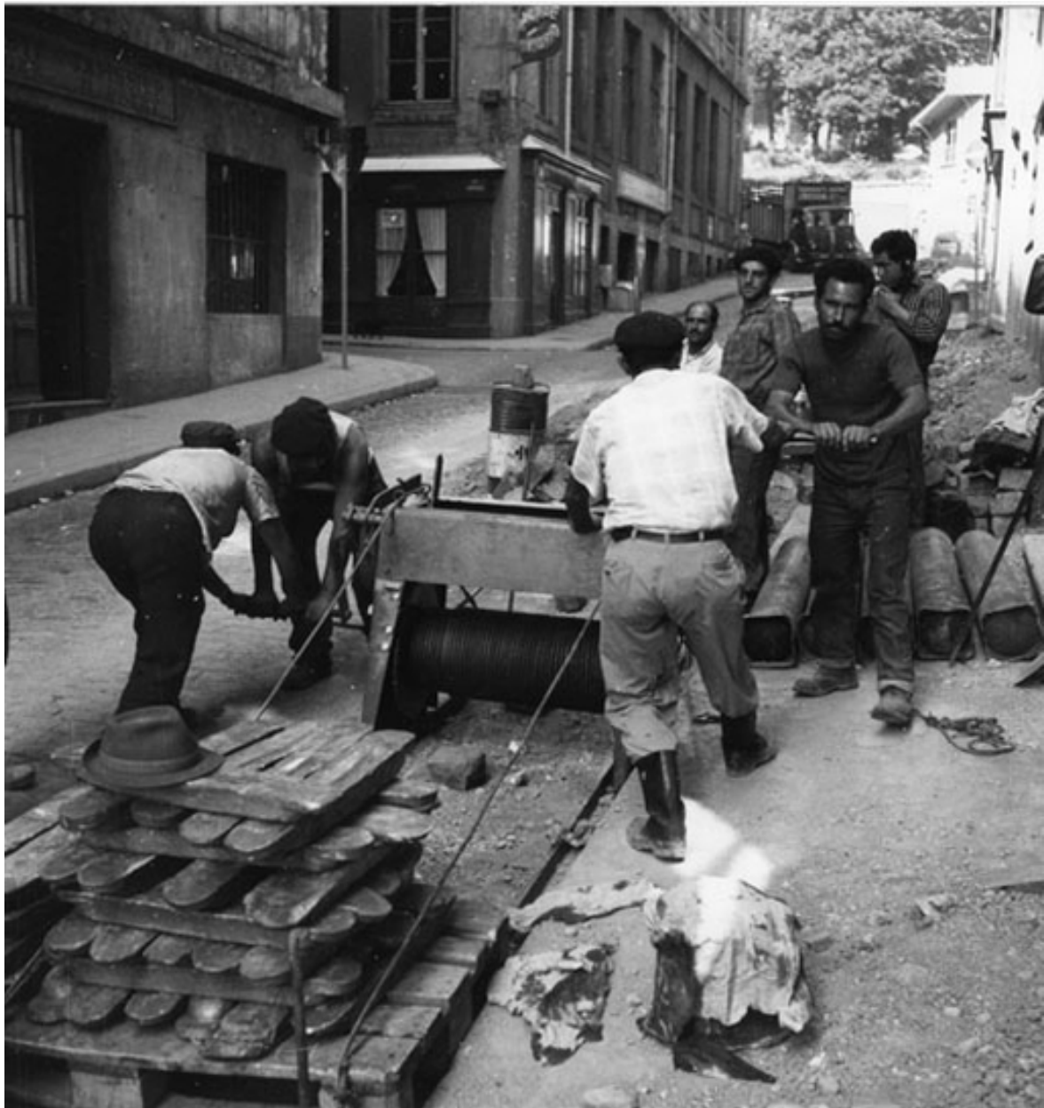
Pose de câbles à la Croix-Rousse, archives privées Société Nexans
