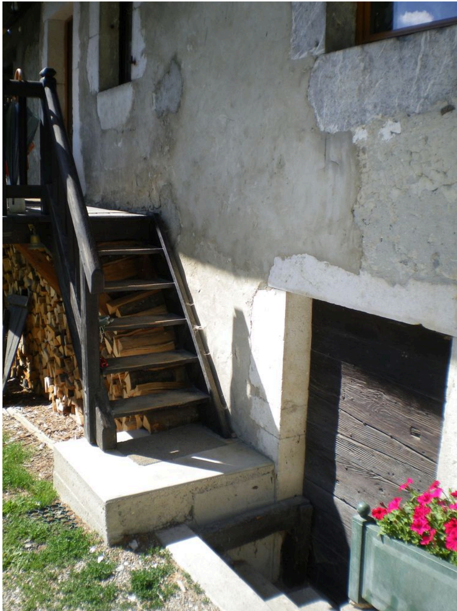
Vue de la porte de la cave.
