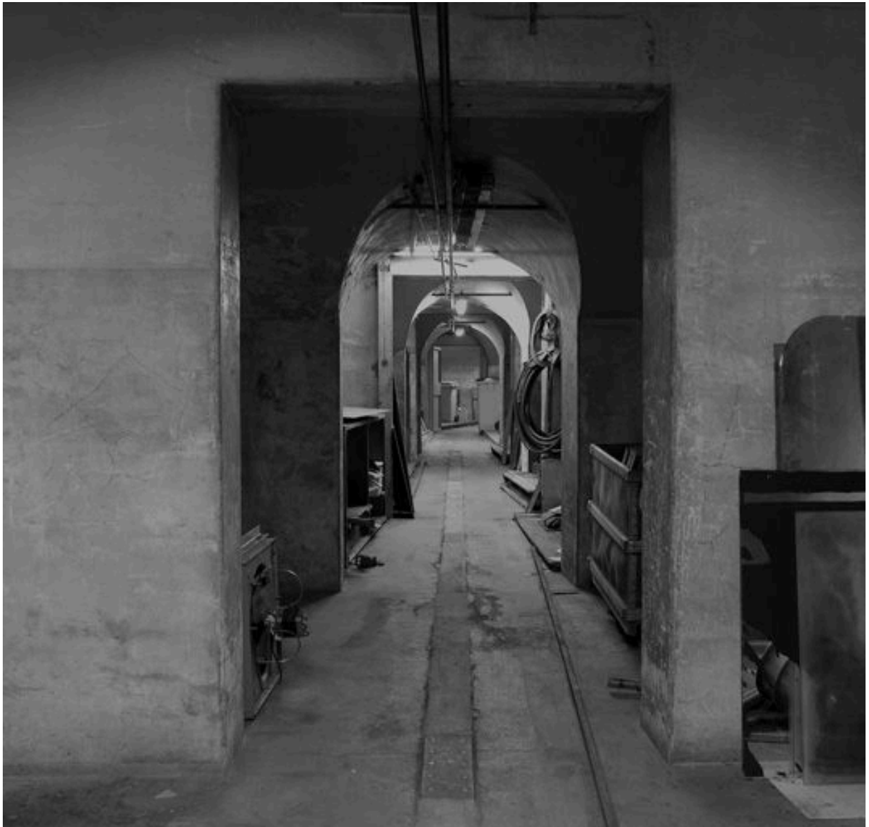
Sous-sol rue Tupin couloir central nord-sud : vue depuis le nord
