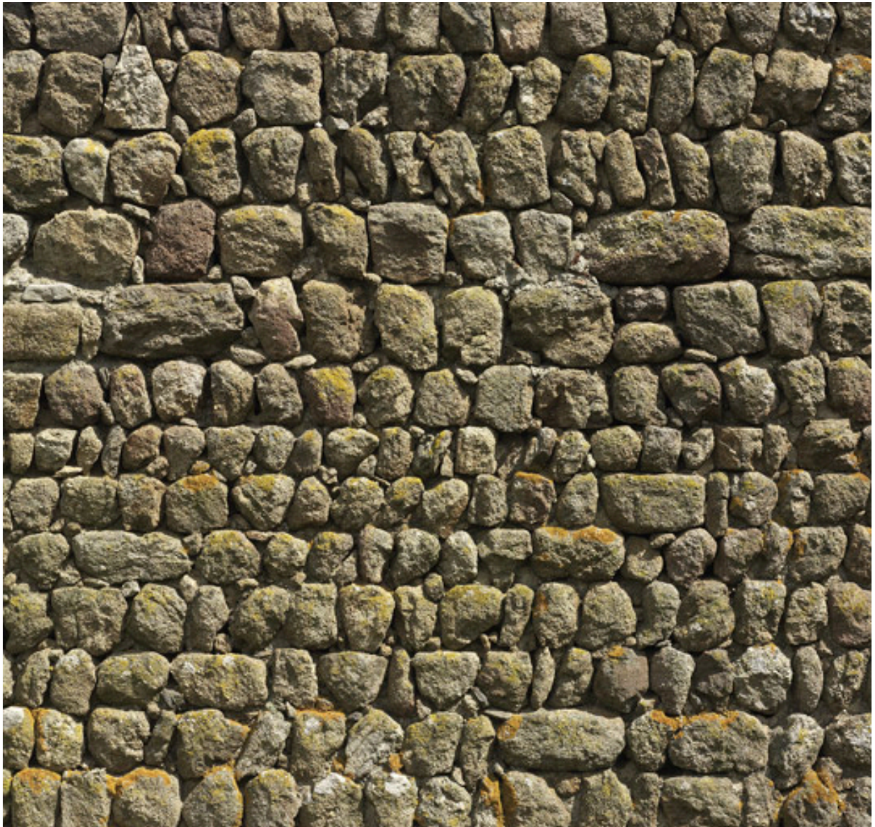
Mur pignon de la grange-étable : détail de l'appareillage à petit moellon sur chant.
