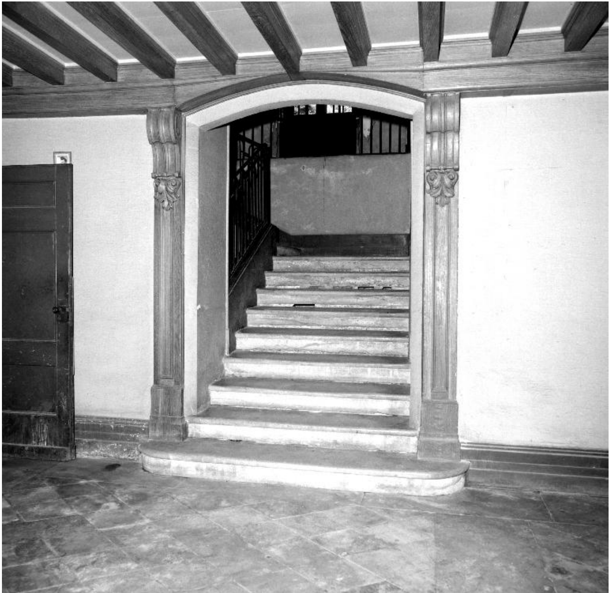
Etage de soubassement : vestibule et départ de l'escalier d'honneur
