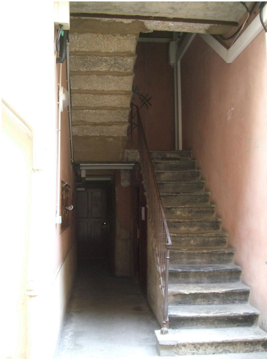
Escalier à jour central rampe sur rampe
