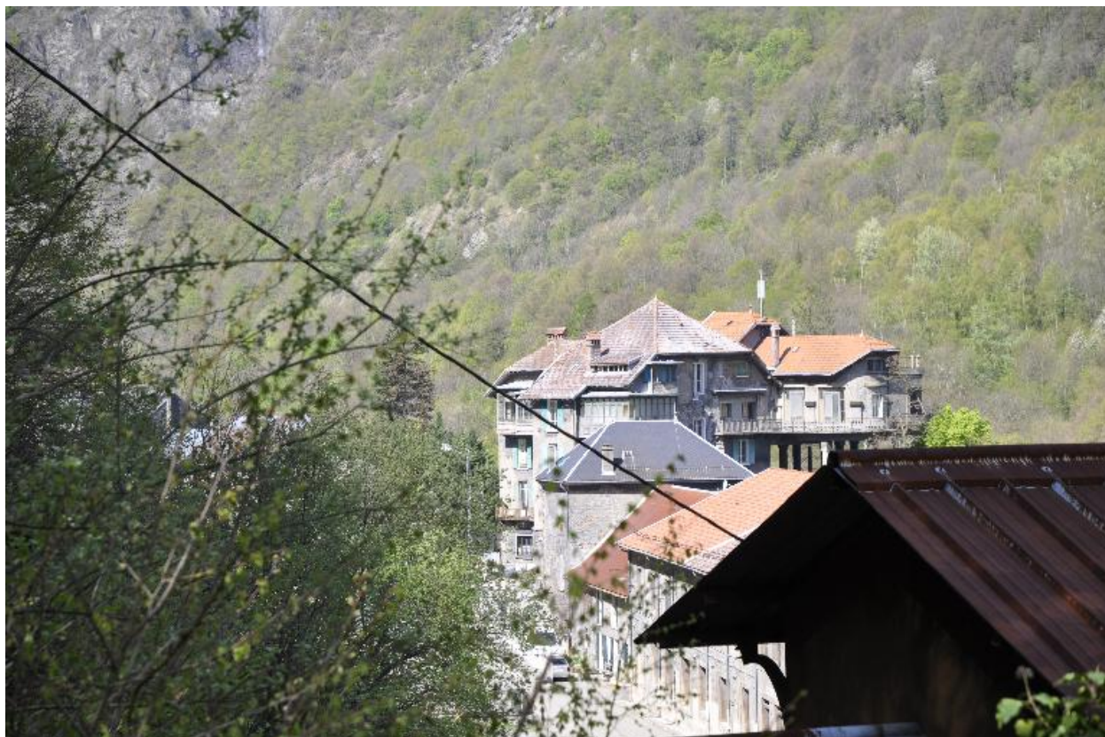
Vue d'ensemble de l'ancienne maison des ingénieurs
