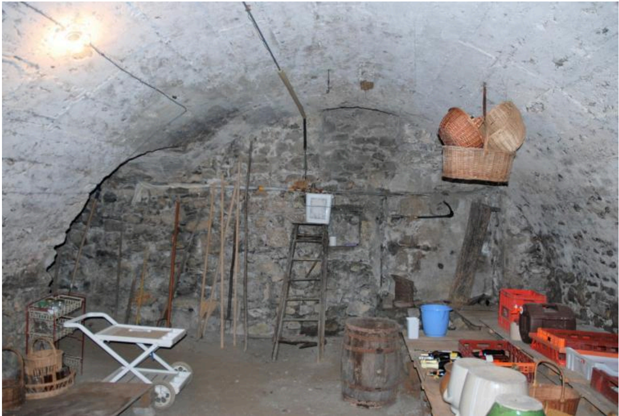
Sous-sol, première cave voûtée en berceau plein-cintre, vue vers l'entrée située à l'ouest.
