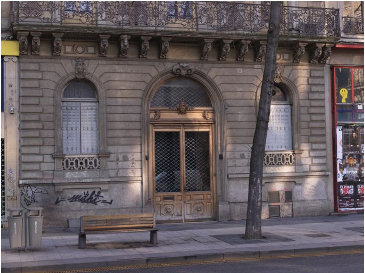
Vue de la porte principale au 16 rue de la République.
