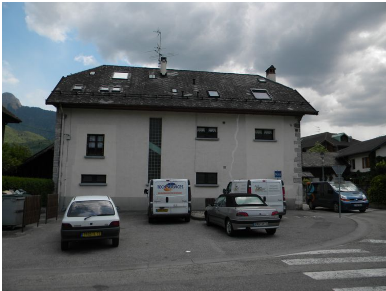
Façade ouest d'une maison très transformée près de l'église (C5 2582).
