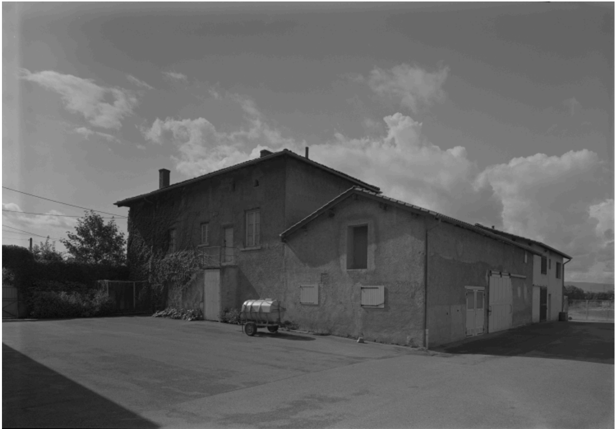
Ferme de type D, située sur la commune de Jassans-Riottier, au lieu dit La Place, parcelle A4 231. Vue partielle : logis et dépendances agricoles.
