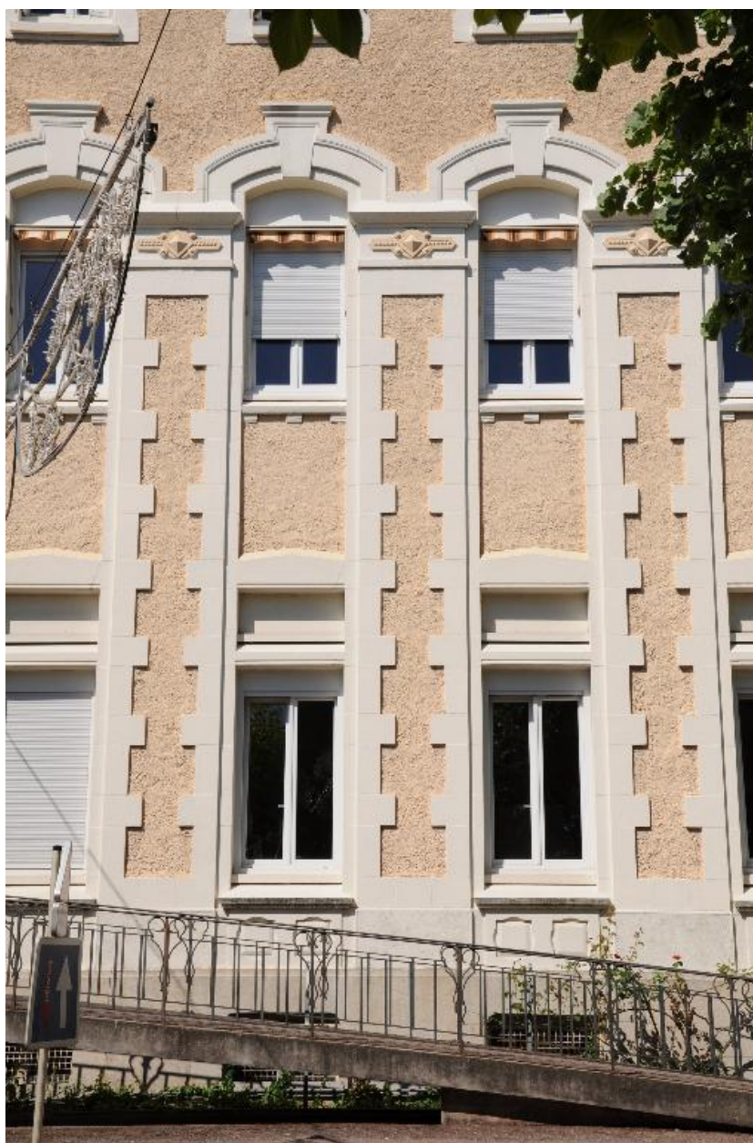
Façade principale, détail du décor architectural
