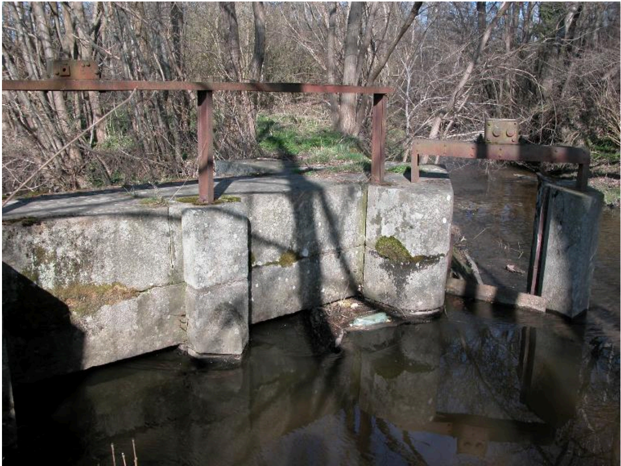
Vue partielle amont de la prise d'eau avec vanne, à droite, de trop plein.
