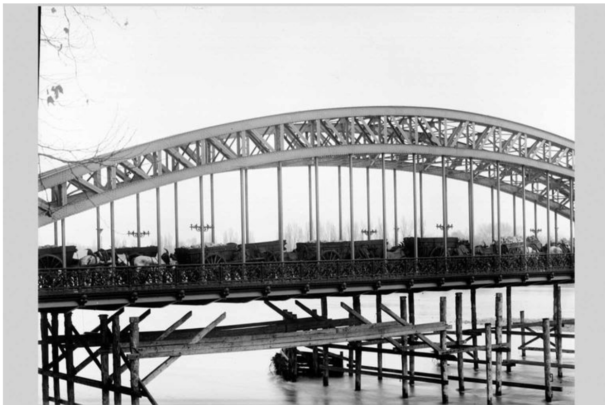
La construction du pont de la Boucle. L'épreuve de charge. Photogr., [1903] (Arch. mun. Lyon. 15 Ph 1837)
