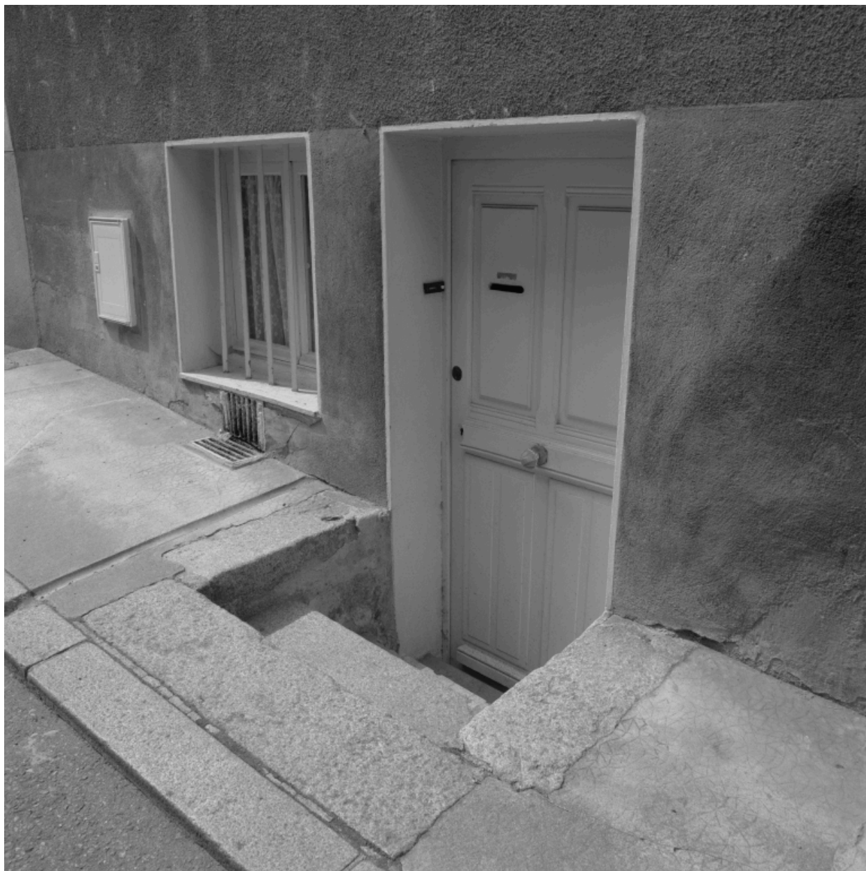
Boën, îlot 13, Ph. Raymond (rue) 20. Détail huiseries de la façade sur rue, vue de la porte d'entrée.
