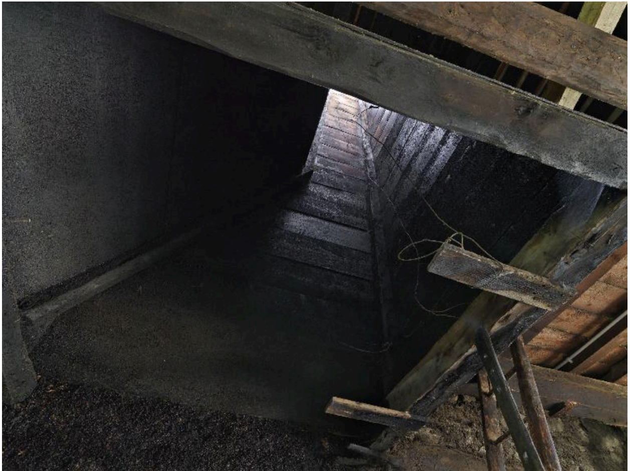
Vue intérieure : salle de fabrication, conduit de la cheminée.
