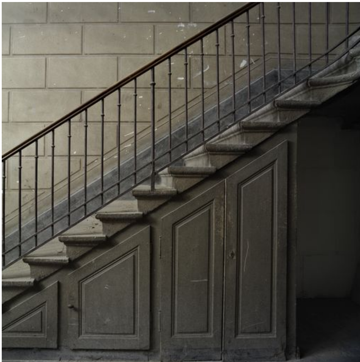
Escalier ouest, détail de la première volée
