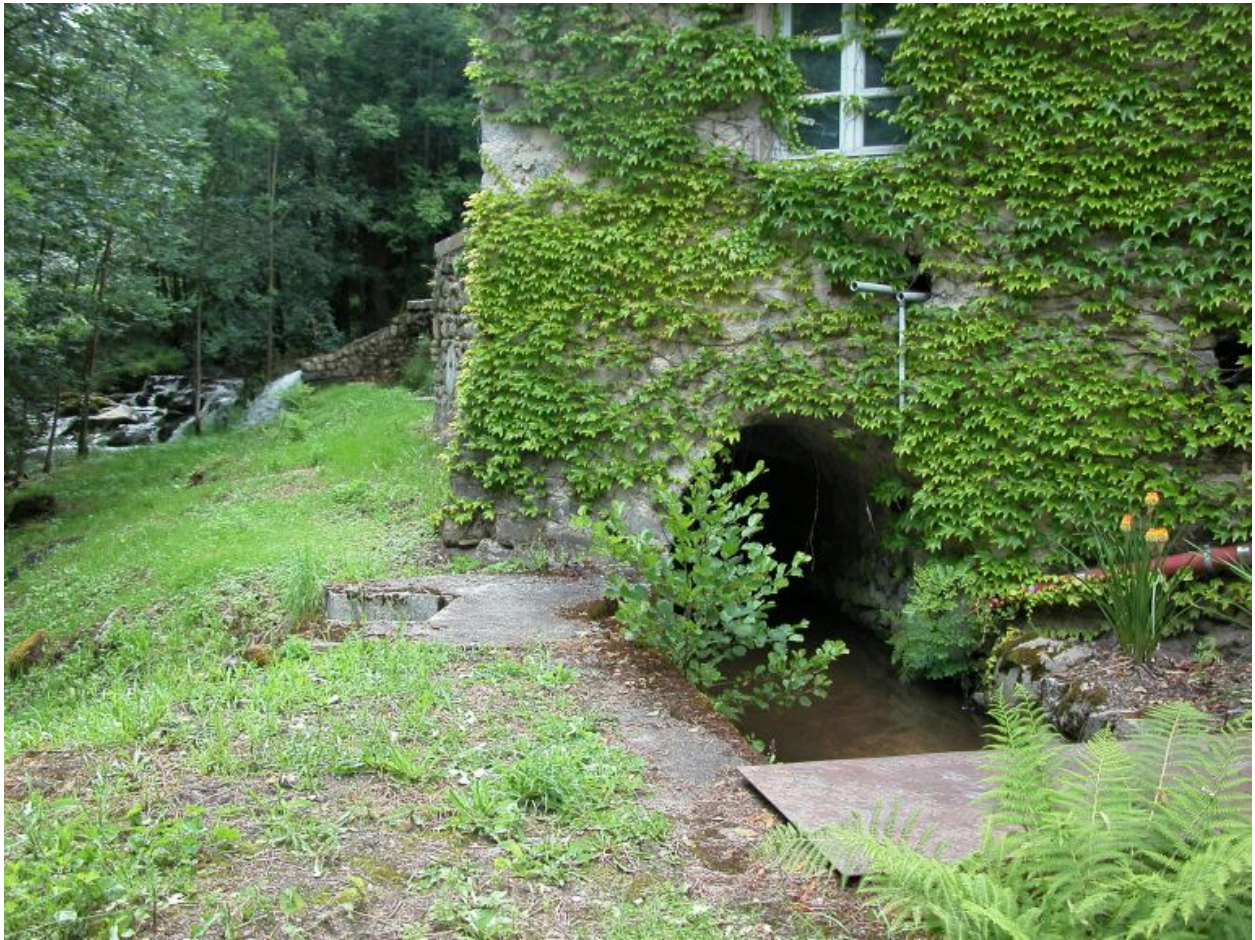
Vue d'ensemble du canal de fuite sur le mur pignon sud du moulin.
