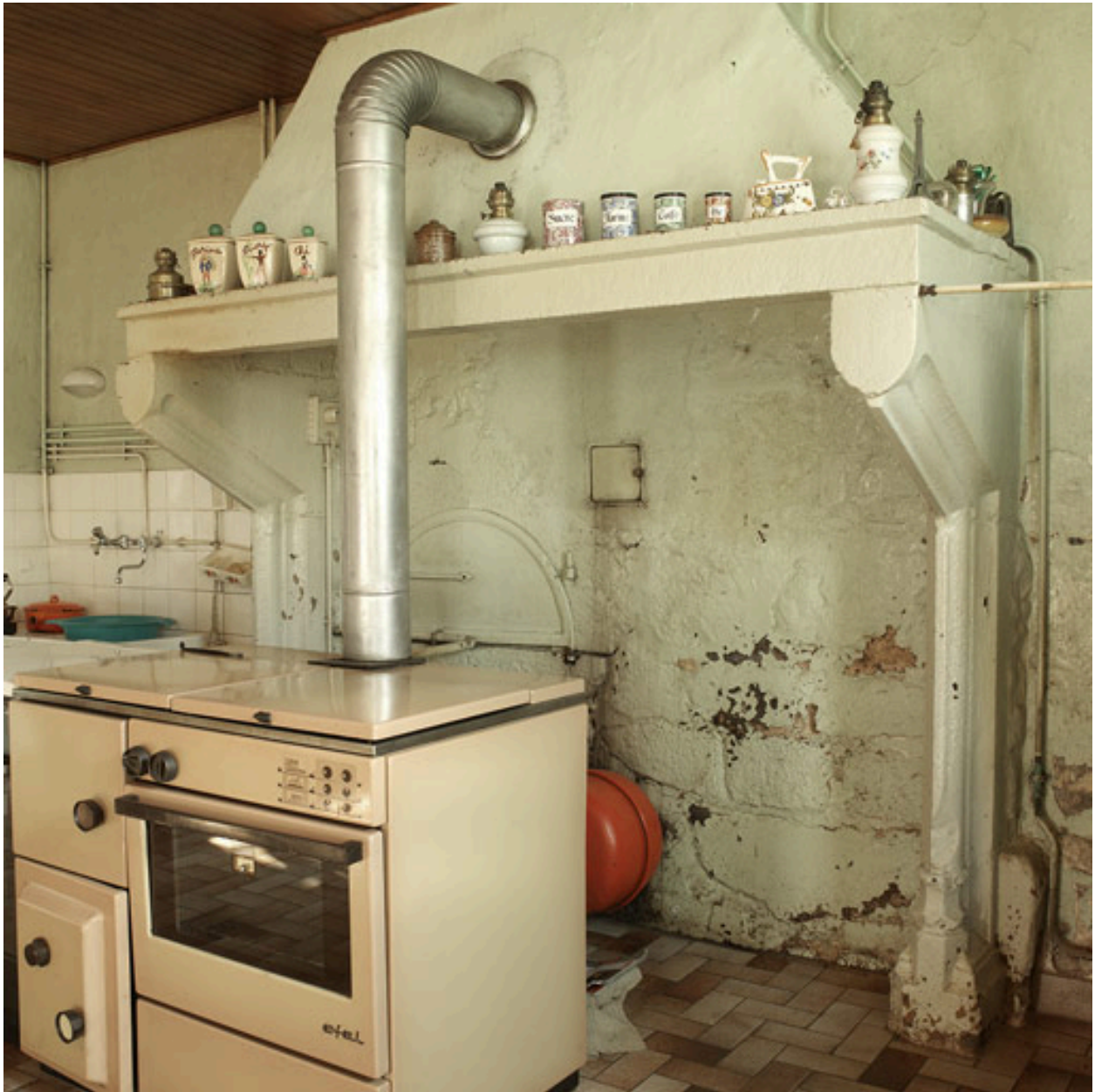
Vue intérieure de la cuisine : cheminée avec piédroits en remploi.
