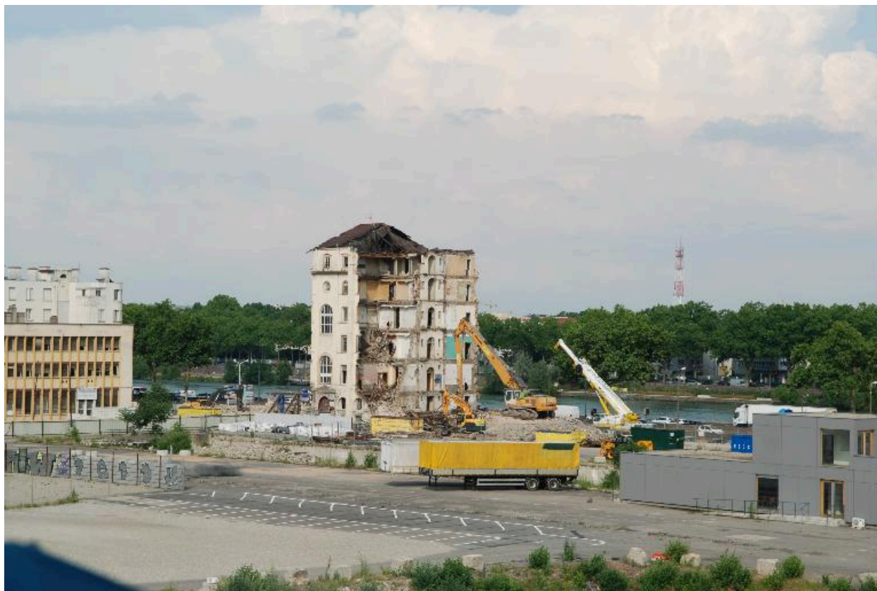
L'immeuble en cours de démolition
