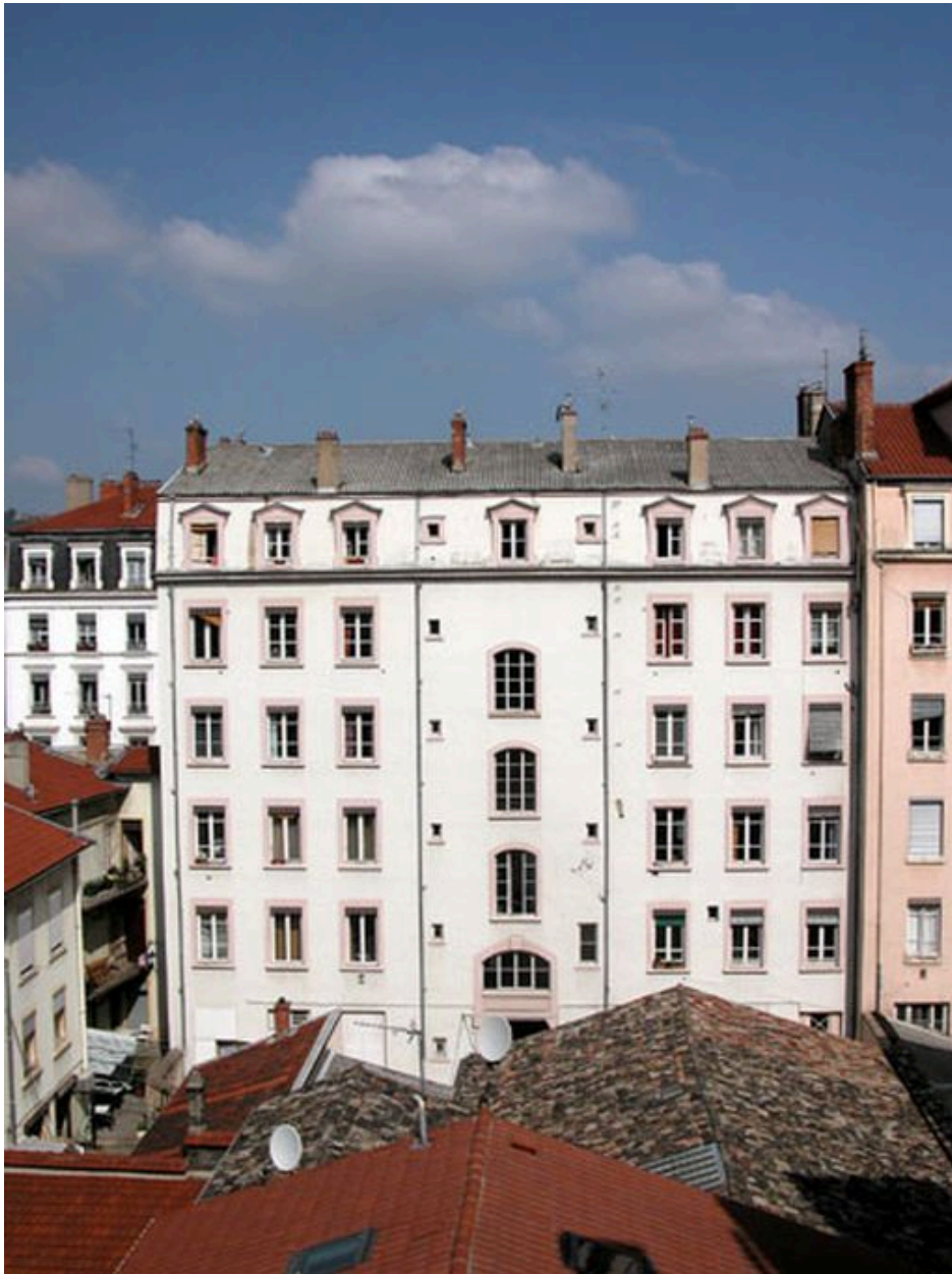
Élévation postérieure depuis un immeuble de la rue Jean-Jaurès
