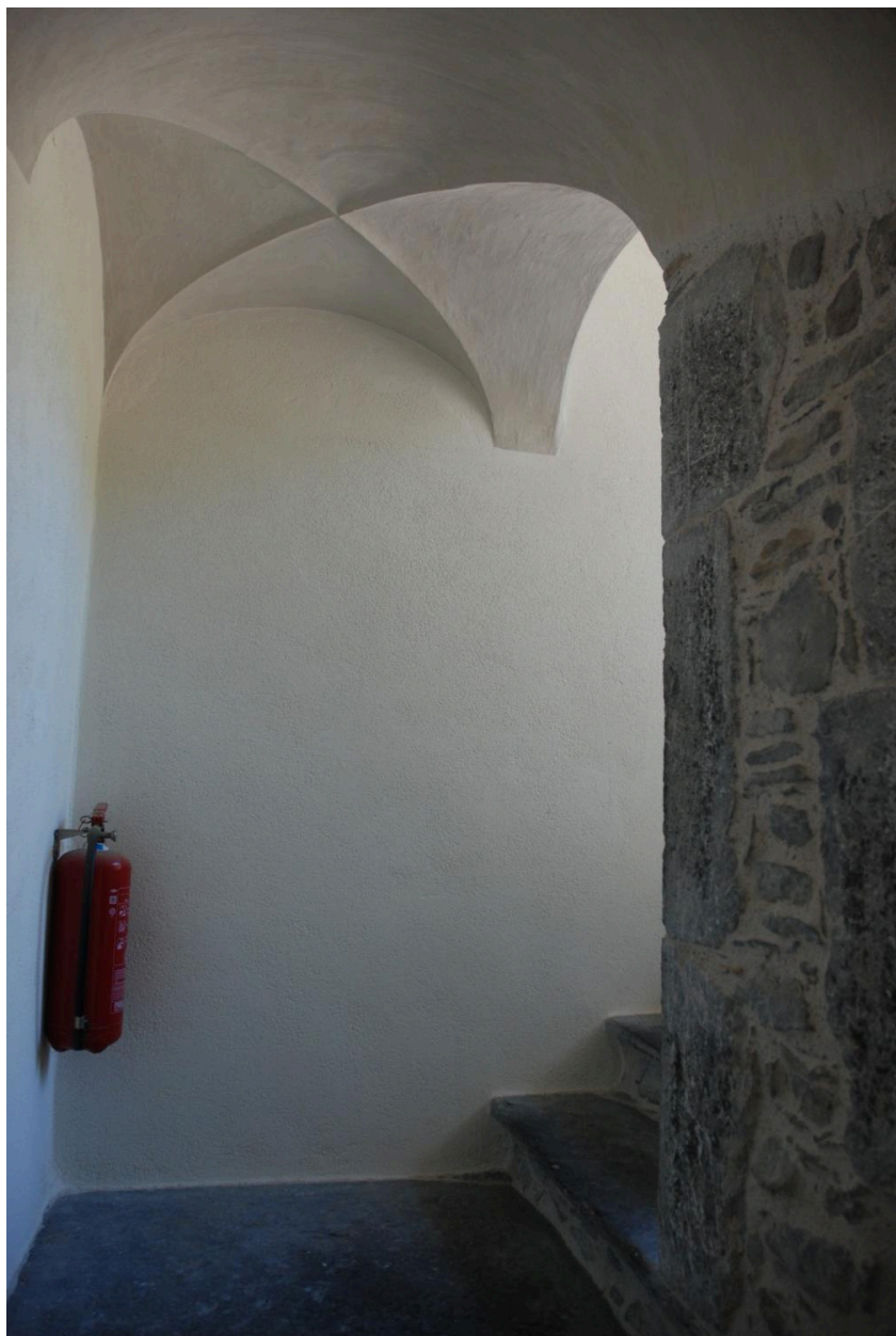
Vue de l'escalier : palier voûté d'arêtes.
