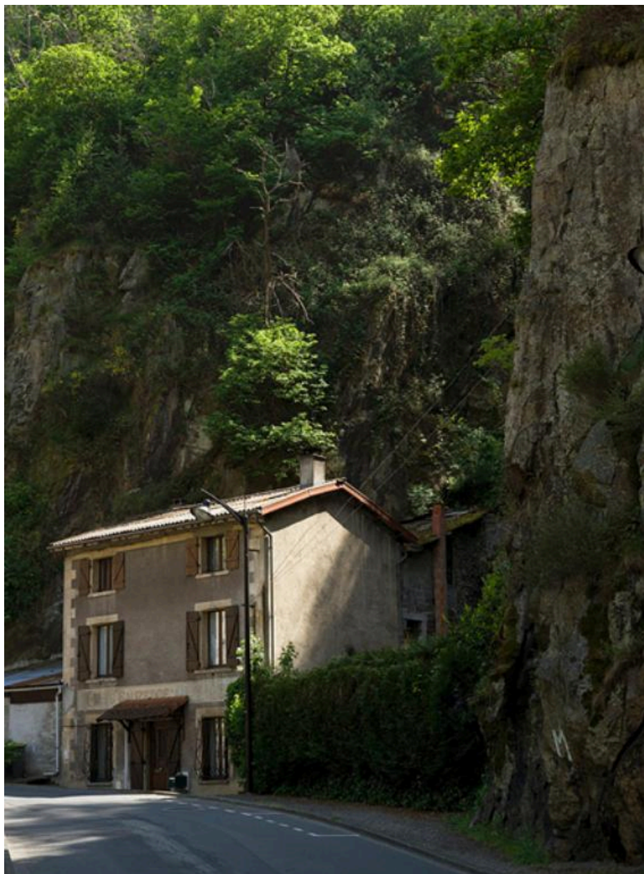
Maison adossée au versant, avenue Joseph-Claussat, dans la Vallée des usines.
