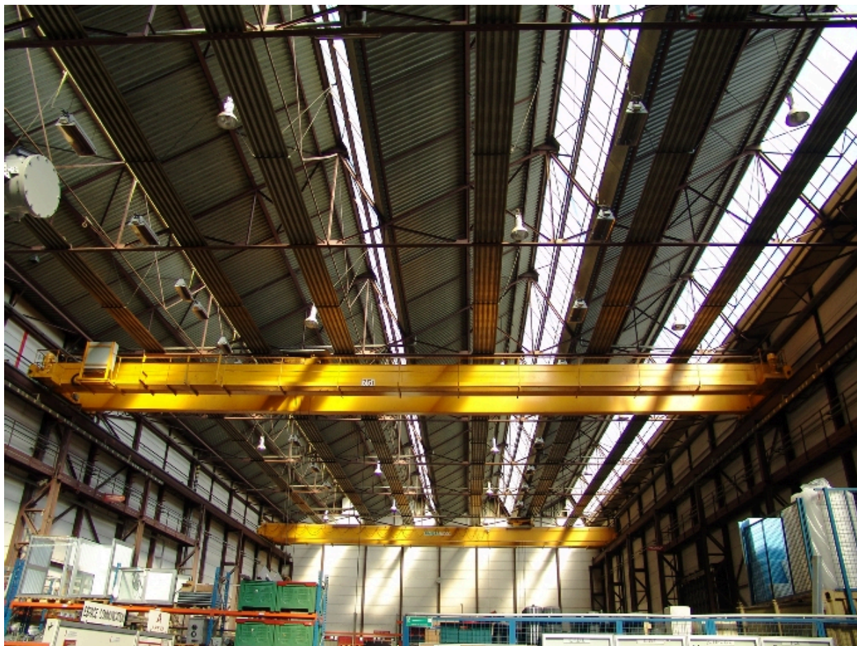
Verrières des sheds et ponts roulants de la halle RM1
