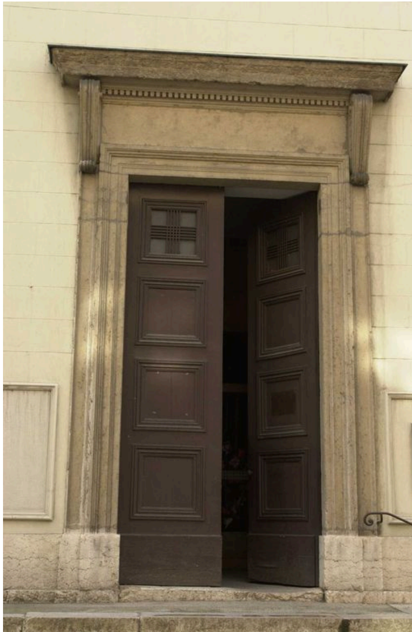
Porte latérale droite de la façade principale
