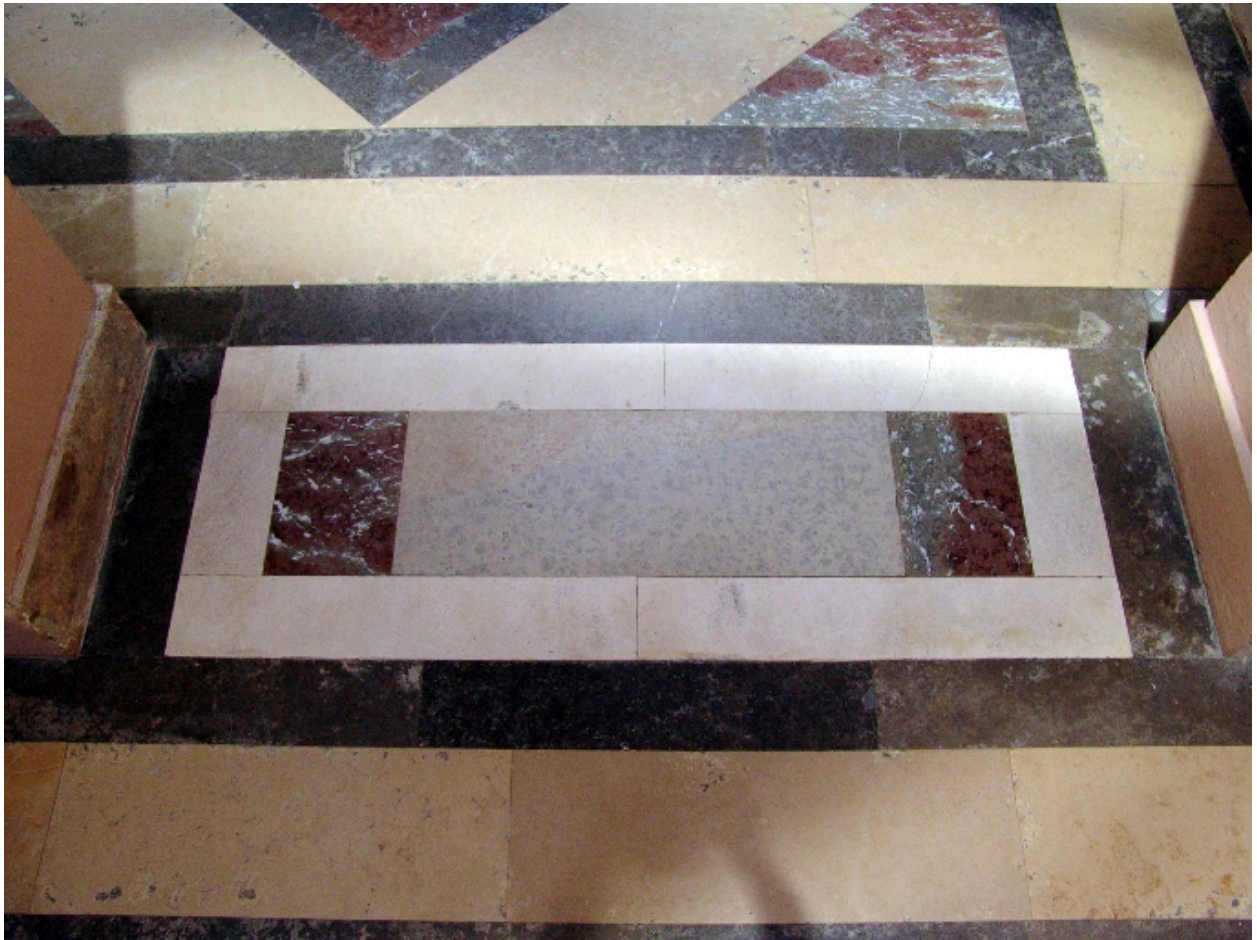
Sol du rez-de-chaussée surélevé : pierre d'Echaillon et marbre de la Vermaz
