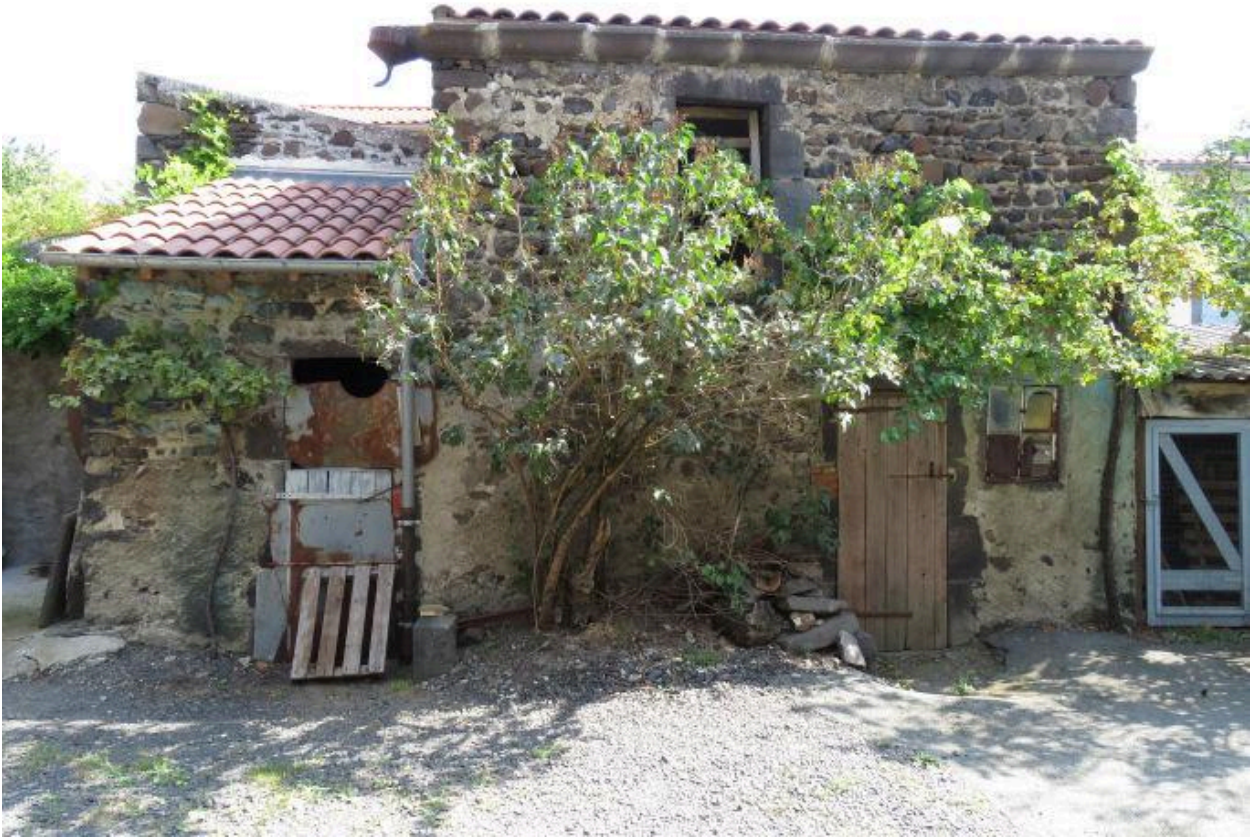
Vue générale : ancienne étable avec fenil et soue
