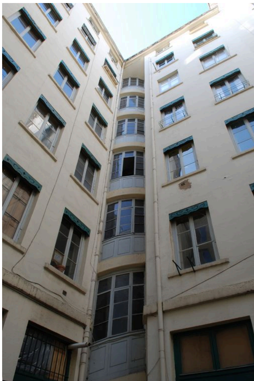
Elévation postérieure ouest
