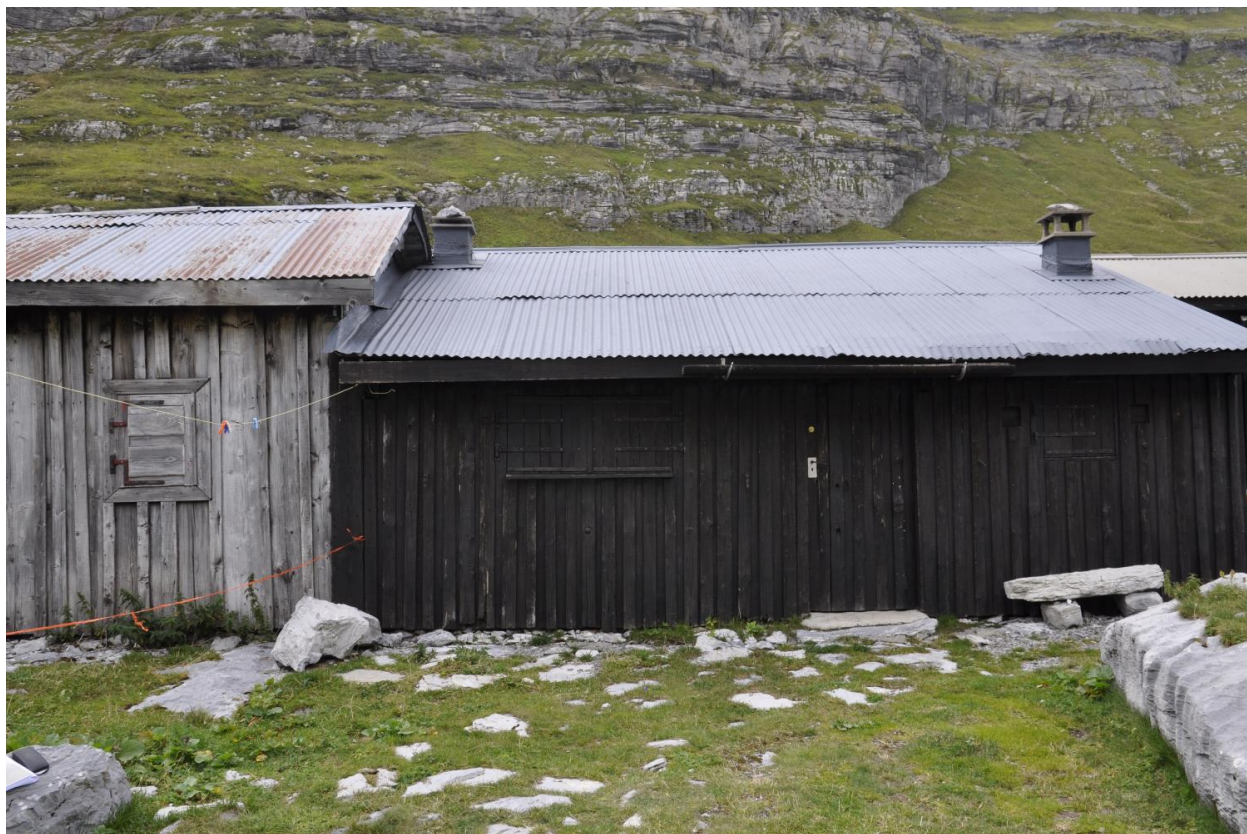
Vue de la façade antérieure est
