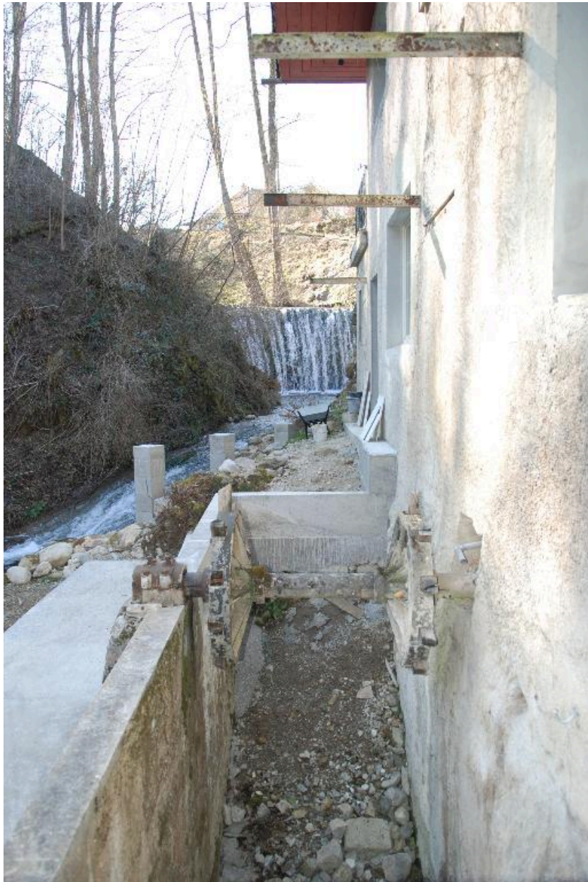
Moulin amont, emplacement ancien de la roue à aube, sens amont.
