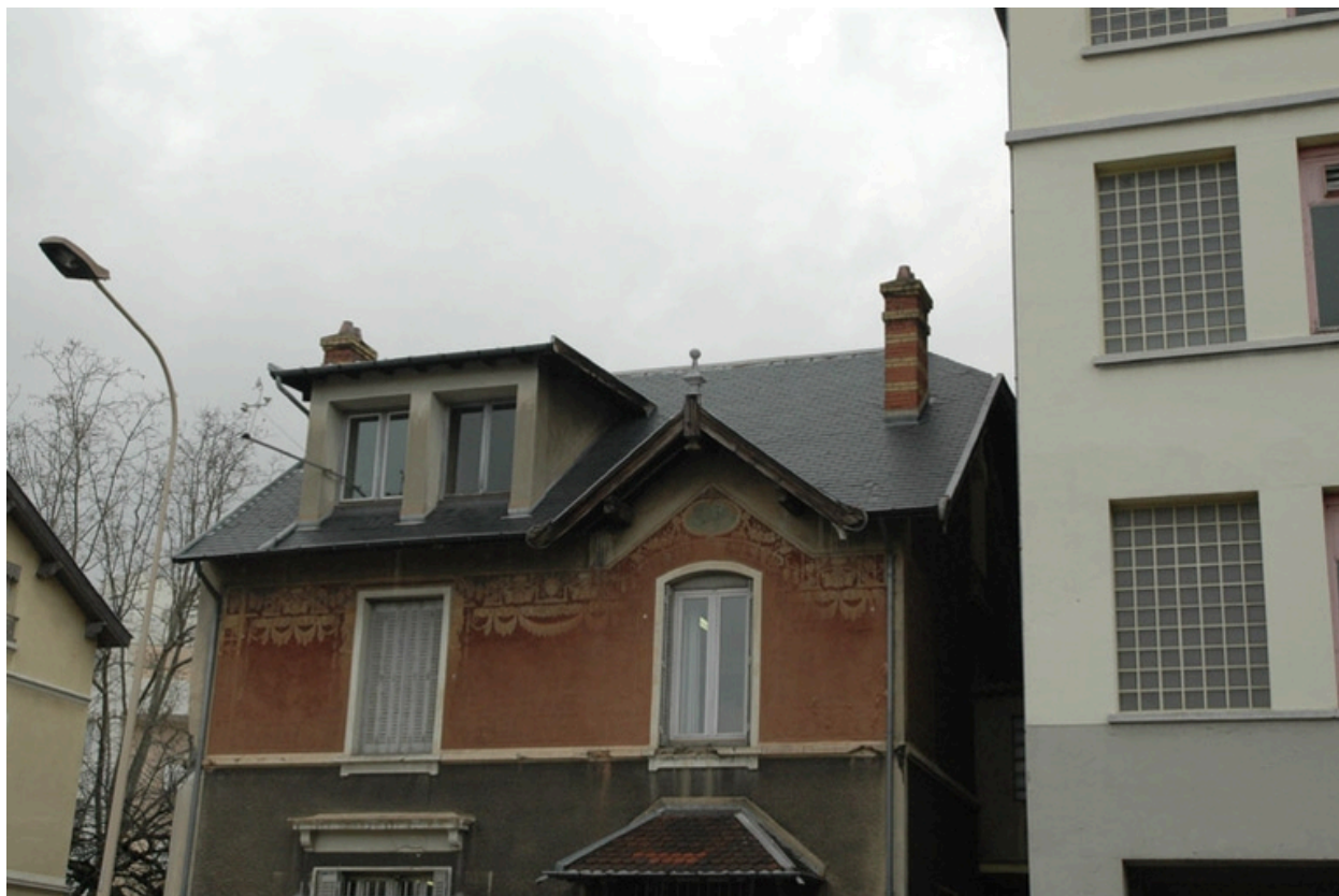
Villa, détail du mur peint, avenue Lacassagne
