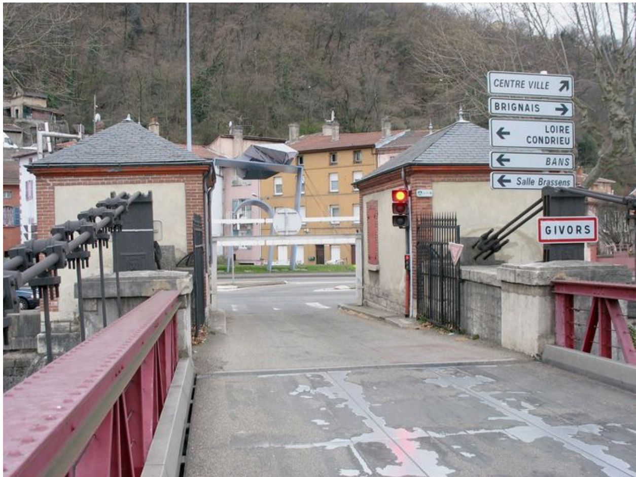
Vue partielle, de dessus, entrée du pont (depuis la rive gauche)
